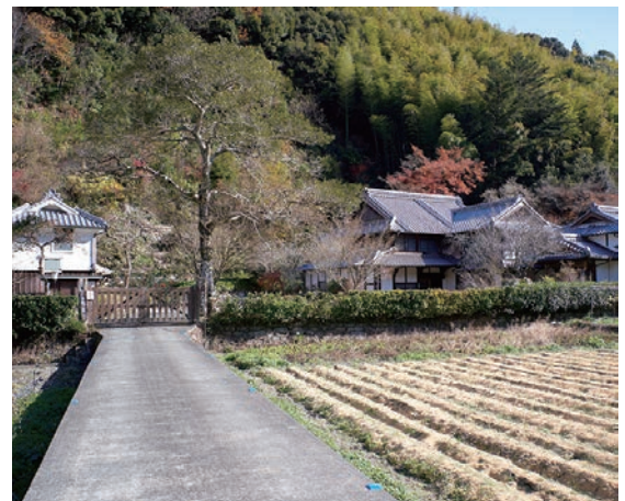
貴重な建築技術が用いられた「旧大内邸」
