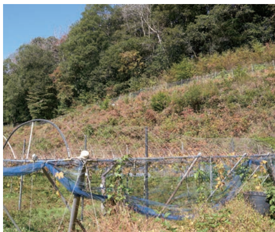
法面の草切りは本当に大変です
