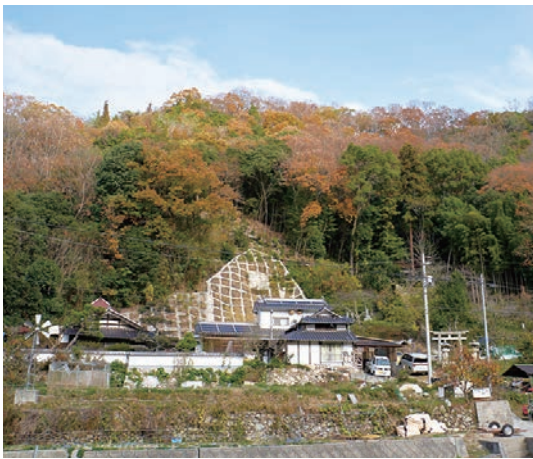
土砂崩れから復旧された裏山
